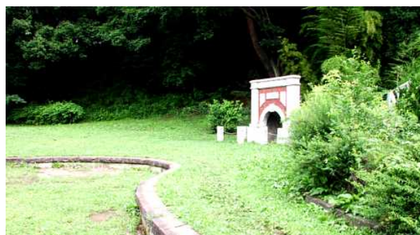
「宮鍋隧道」の現況
