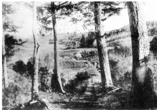
住吉神社から下貯水池方面を望む (「東京市上水道拡張事業報告」第1回)
