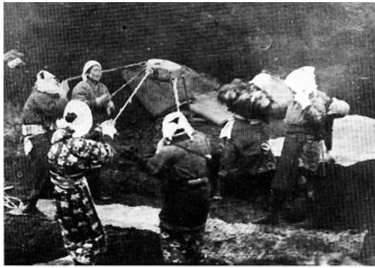
タコつき風景。これで、ローラーのまわれない所をつきかためた。6人用のタコである
