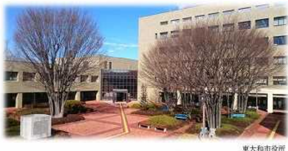
東大和市役所
