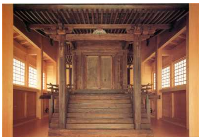
豊鹿島神社本殿 (出典 豊鹿島神社本殿修理工事報告書)
